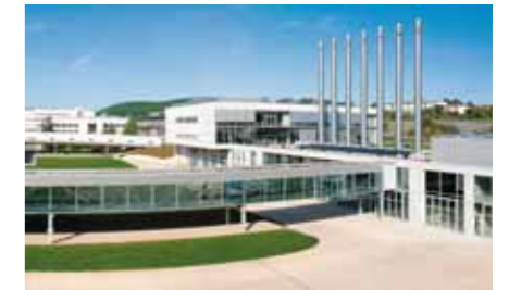
Energiezentrale und Viessmann Akademie (Werk Allendorf)
